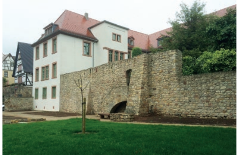
HEPPENHEIM Neugestaltung des Parks am Landratsamt.
