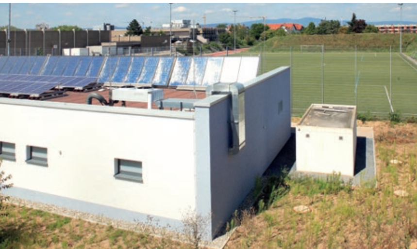
KELSTERBACH Umkleidetrakt mit Photovoltaikanlage.
