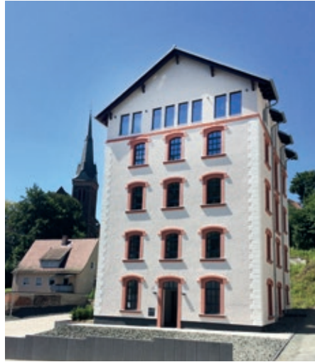
BIEDENKOPF Neuordnung und Sanierung der alten Brauerei.
