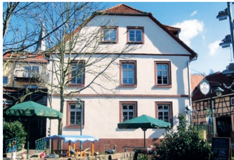
Historisches Wohn- und Geschäftshaus. Alle Fotos.: NH ProjektStadt.
