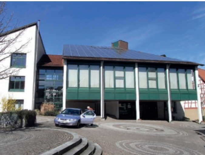
Rathaus mit Photovoltaikanlage.
