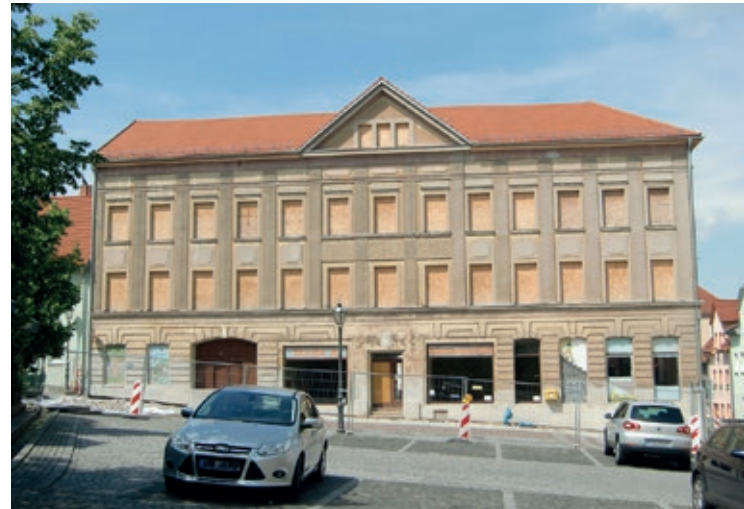
Das wichtige Gebäude Markt 4 an der Stirnseite des Marktes wurde gesichert. Alle Fotos: NH ProjektStadt.
