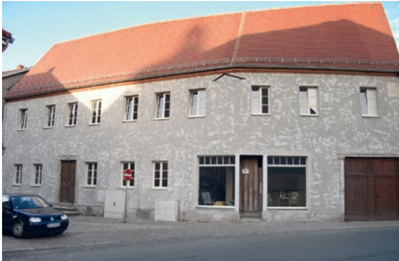
Mit der Sicherung eines der ältesten Gebäude wurde die Sanierung angestoßen.
