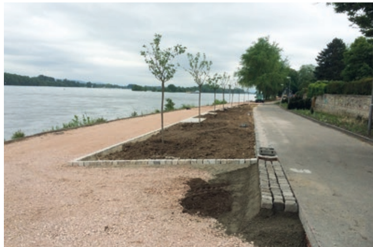
ELTVILLE Pflaster- und Pflanzarbeiten zur Aufwertung der Rheinpromenade.
