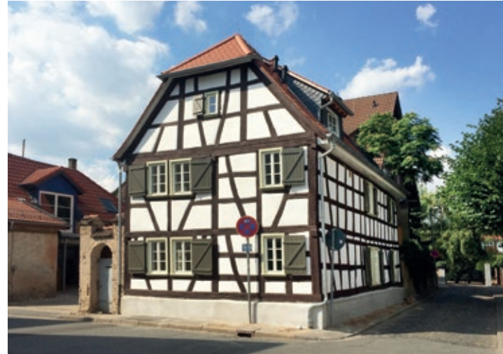
Geförderte, denkmalgerechte Sanierung Schäfergasse 14. Foto: NH ProjektStadt.
