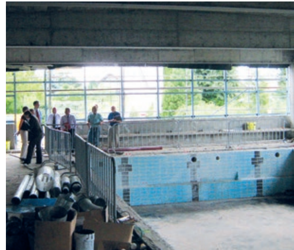
EINHAUSEN Sanierung des kommunalen Hallenbades. Alle Fotos: NH ProjektStadt.
