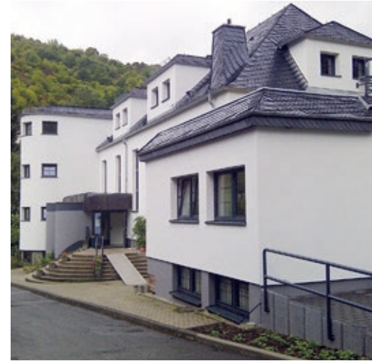
LORCH Das sanierte Lorcher Bürgerhaus. Alle Fotos: NH ProjektStadt.
