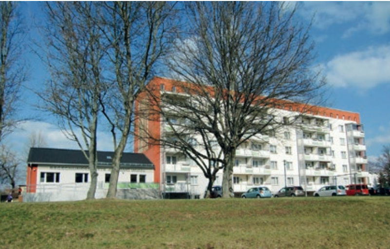
Rückbau und Modernisierung von Wohnraum sowie der Begegnungsstätte.
