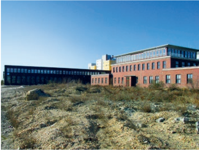
KELSTERBACH Graf-De-Chardonnet-Platz 2012: das ENKA-Areal kurz nach dem Rückbau der altindustriellen Anlagen und Gebäude.
