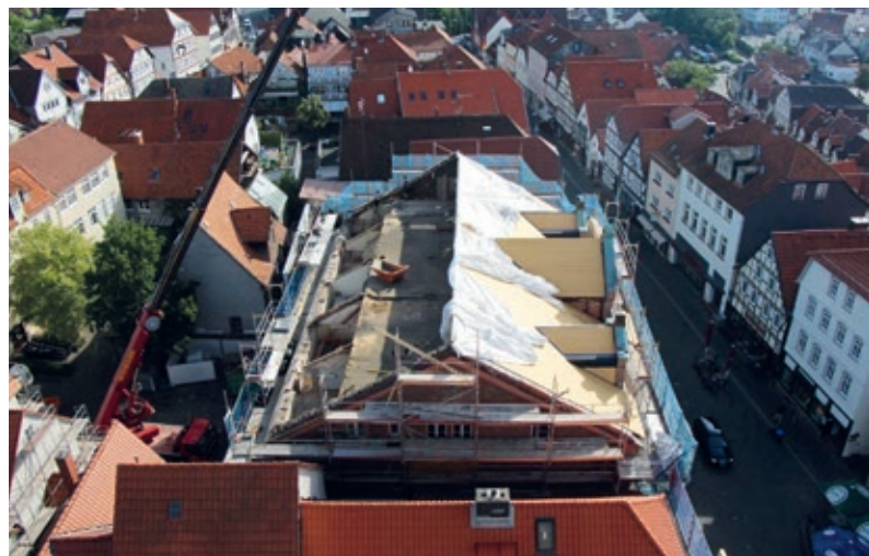
Das Rathaus wird zurzeit umfassend saniert. Foto: NH ProjektStadt.
