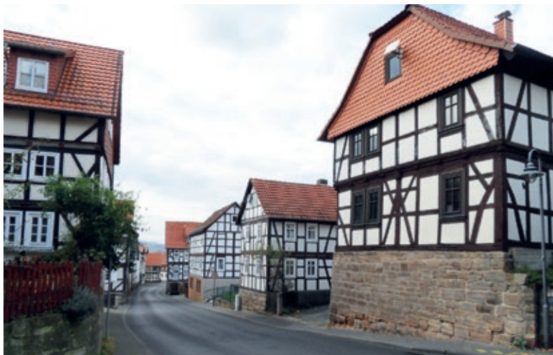
HERLESHAUSEN Historische Fachwerkbauweise in der Bahnhofstraße.
