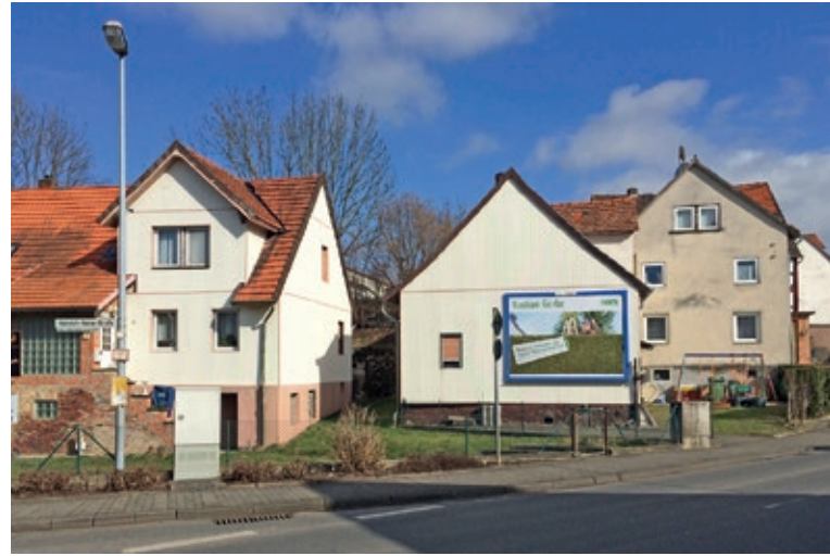
HEILIGENRODE Stark sanierungsbedürftige Bausubstanz im Ortskern. Alle Fotos: NH ProjektStadt
