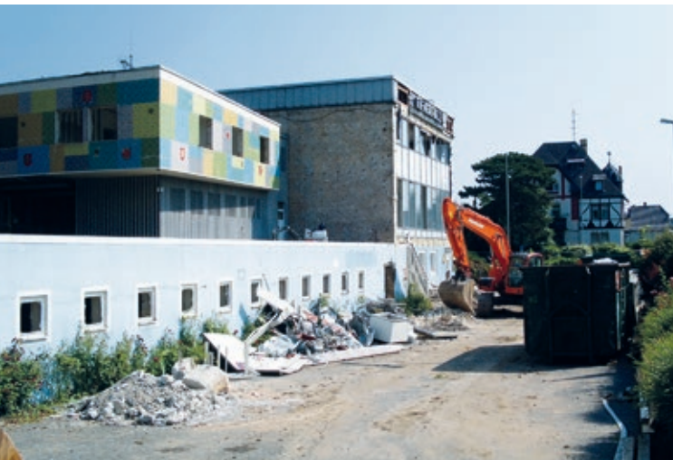
ELTVILLE Abbruch der Rheingauhalle.
